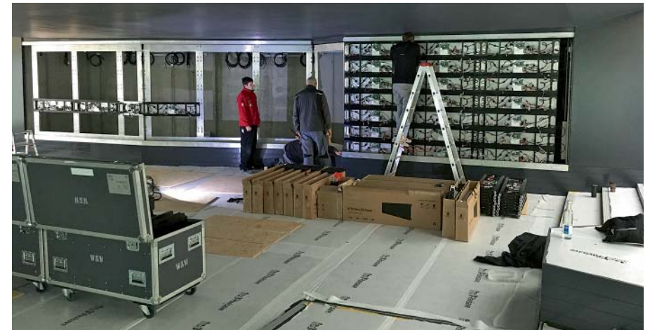
Aufbau der LED-Wand-Elemente an den verschiebbaren Metallkonstruktionen
